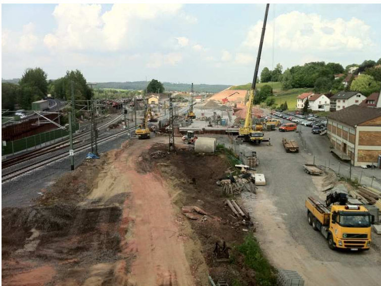
... und mit Blick auf den begangenen nördlichen Baustellenteil.
