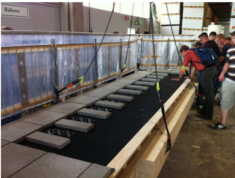
Besonders beeindruckend: ein vorgefertigter Balkon einschließlich Geländer und Plattenbelag auf Abdichtung
