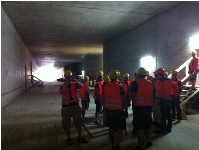
... beim Durchgang durch den Rohbau des Tunnels ...
