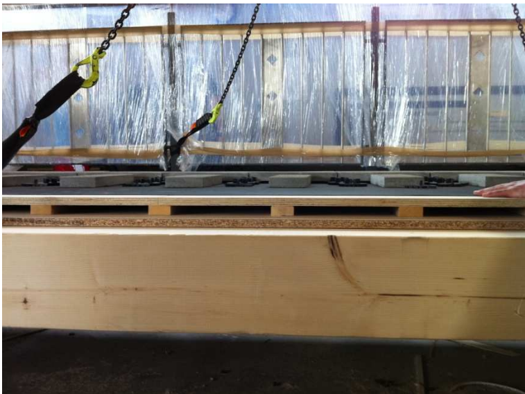
Das Element ist verladefertig vorbereitet, einschließlich Vorkonfektion aller seiner Einbauteile
