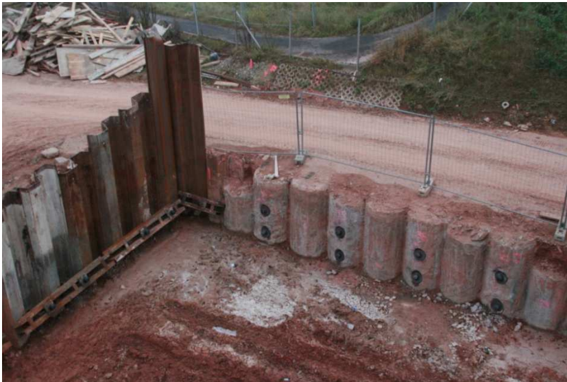
... gespundet und mit rückverankerter Bohrpfehlwand, vorbereitet für das Bauen im Grund- wasser
