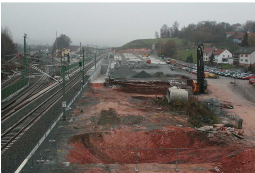
Blick auf den fertig- gestellten Bahnhof Neuhof mit P+R- Parkplatz auf der Tunneldecke
