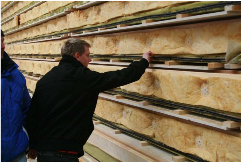
Fachmännische Kontrolle der Luftdichtheitsebene fertiggestellter Deckenelemente
