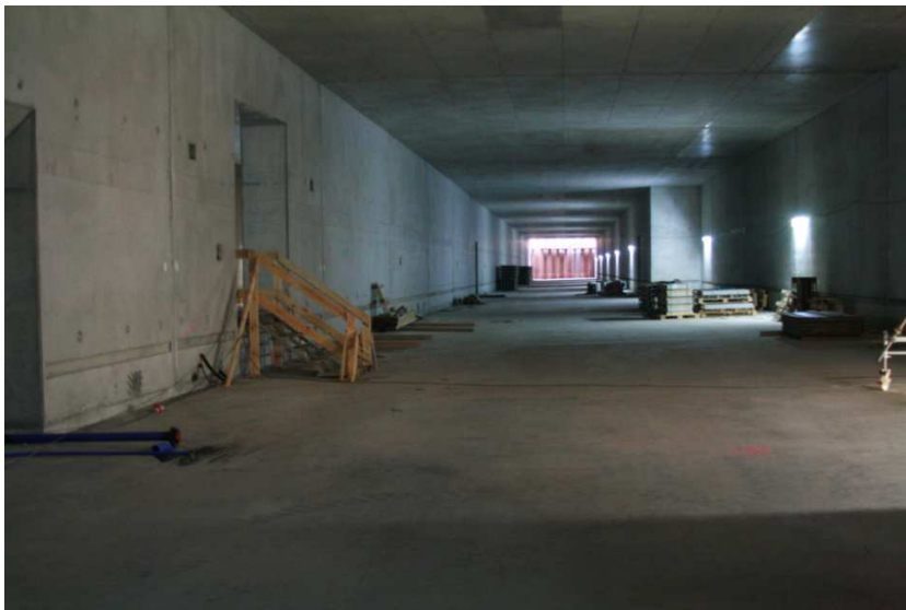
„Tunnelblick“ in Richtung Fulda: fertiggestellter Rohbau des 600 m langen Teilstücks
