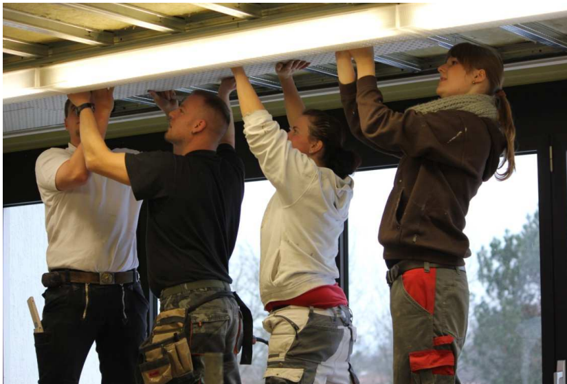
Bild 1 Teamwork – Studierende der Technikakademie Alsfeld bei der Deckensanierung ihrer Klassenräume
