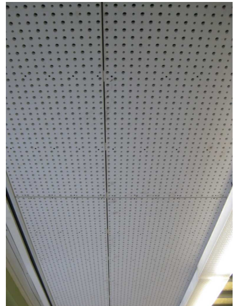
Bild 4 - GK-Lochdecke (unverspachtelt) mit versetzter Rundlochung ohne Demontage der Beleuchtung
