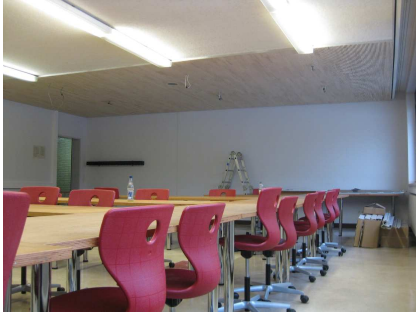
Bild 5 – Akustikelemente aus astreiner Weißtanne im hinteren Raumdrittel als sehenswerte Holzbaulösung (noch ohne Beleuchtung)
