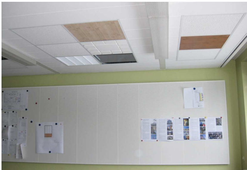
Bild 2 Mineralfasersystem mit Musterflächen in Kombination mit Pinnwandabsorber als Präsentationsfläche
