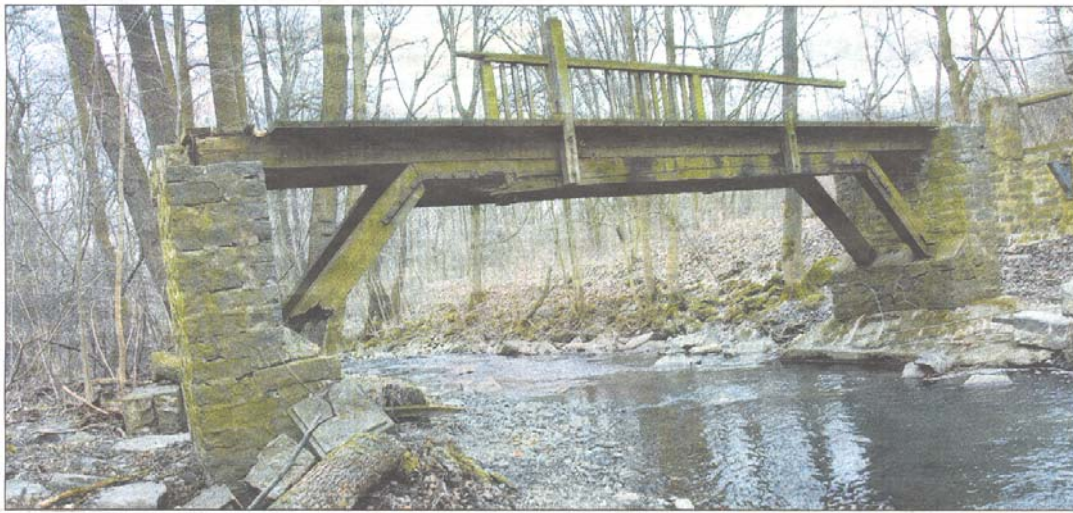
Eine Nachfolgelösung wird gesucht: der marode und halb abgebrochene Jungfernsteig in den Alsfelder Erlen. Foto: gk
